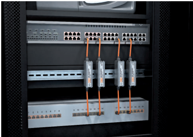
Рис. 3.81 Рекомендация по защите на коммутаторе с коммутационной панелью. УЗИП заземлены через DIN-рейку, на которой они закреплены.
