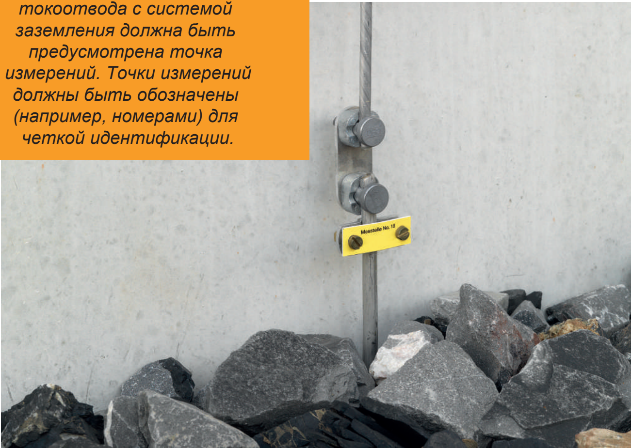
Рис. 2.48: Точка измерения на вводе в землю
