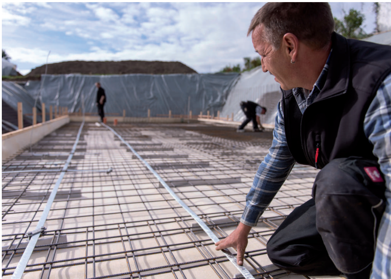
Рис. 2.75: Прокладка фундаментного заземлителя
