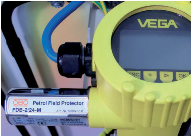
Рис. 3.66: Сенсор с Petrol Field Protector (см. поз. 7 на рис. 3.68)
