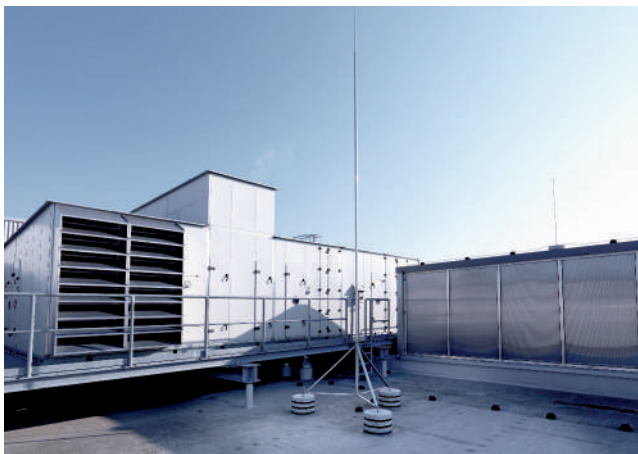
Рис. 2.22: Изолированная молниезащита с молниеприемной мачтой isFang
