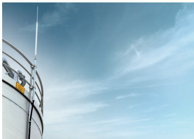
Рис. 2.58: Изолированная молниезащита с проводом isCon®
