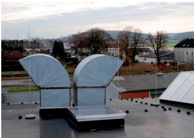
Рис. 2.24: Изолированная молниезащита со стеклопластиковыми держателями
