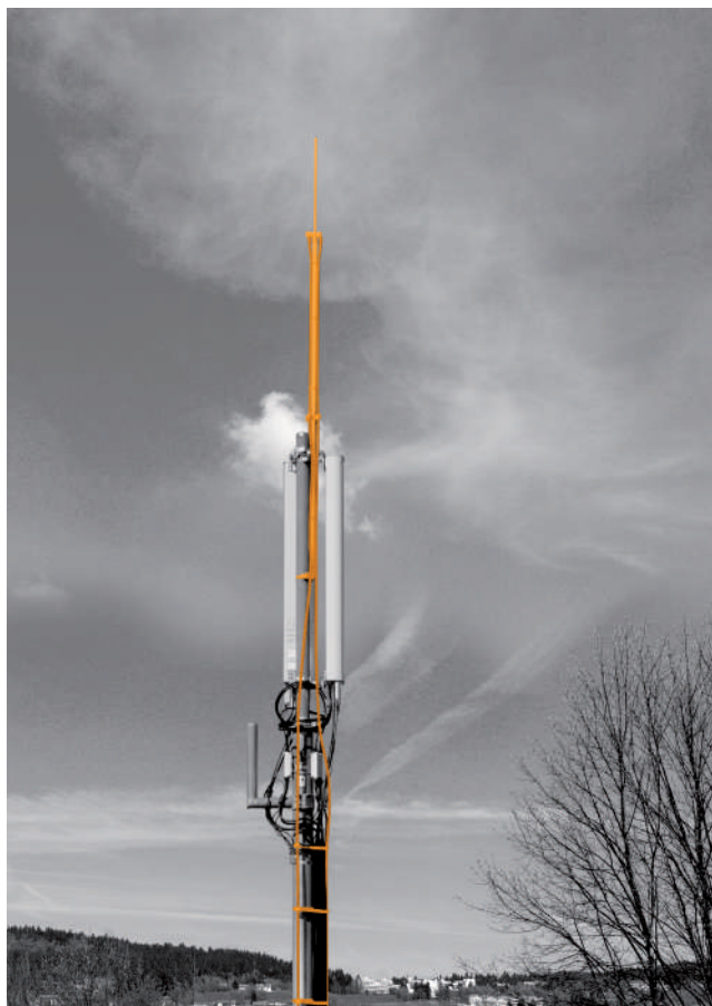
Рис. 2.72: Мачта мобильной радиосвязи с проводом isCon®
