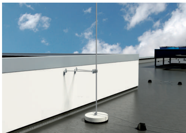
Рис. 2.57: Изолированная молниезащита с изолированными траверсами
