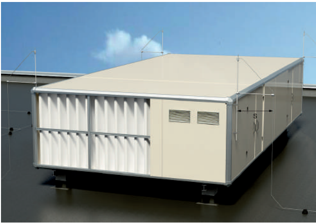
Рис. 2.28: Изолированный молниеприемник с разделительным интервалом (s)
